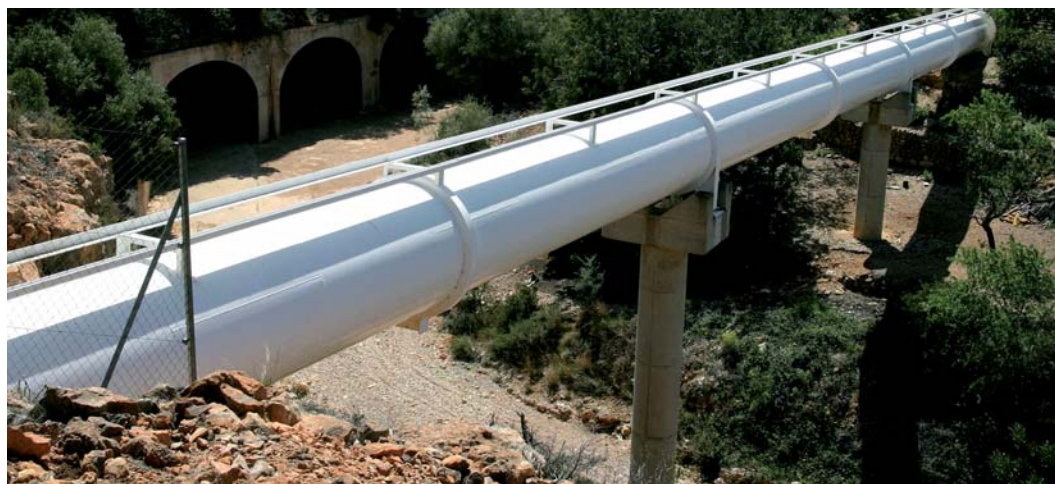
Obras del trasvase del Ebro a Tarragona, cuya continuación hasta Barcelona fue aprobada por el Gobierno de Zapatero en junio de 2008 y suspendida poco después.
